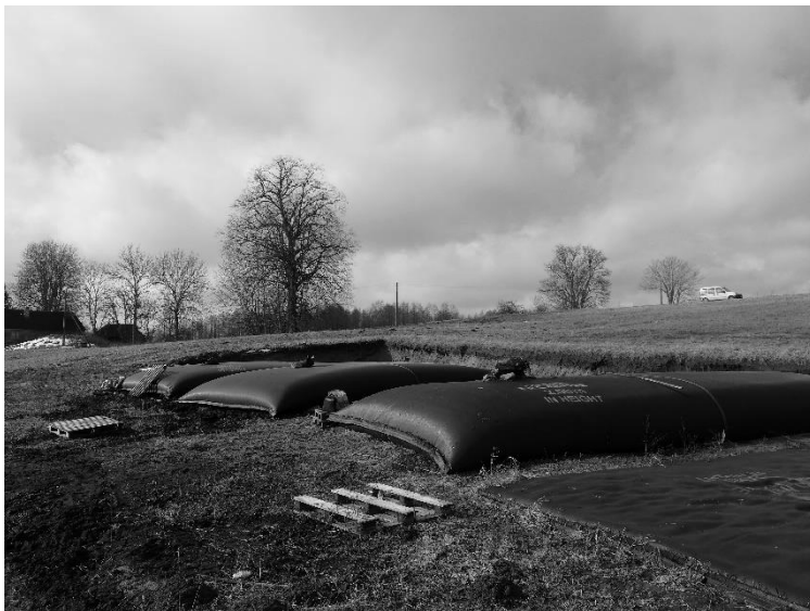
1. att. Ģeotube maisu izvietojums Bižas ezera krastā: trešajā ģeotube maisā no kreisās puses ir ievietoti mitruma sensori.
