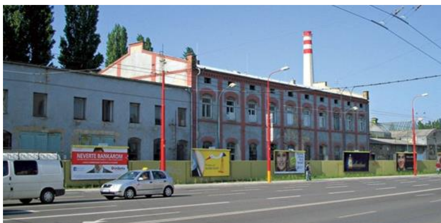
Fig. 12. Kablo Bratislava Factory Source: https://www.asb.sk/fotogalerie/architektura/kablovka-vbratislave-fotoalbum/kablovka-vbratislave-1
