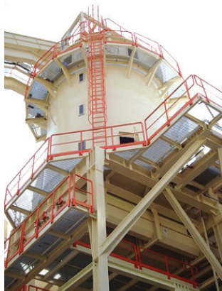
1.37. att. Vertikālā novietojuma kokskaidu bunkurs ar palīgelementiem skaidu izvadei.
