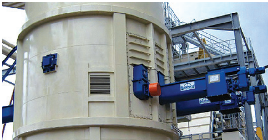
1.36. att. Vertikālā novietojuma bunkurs skaidu uzkrāšanai.
