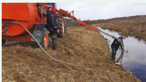
Meliorācijas sistēmas skalošana. Avots: ZS „Vilciņi-1” arhīvs
