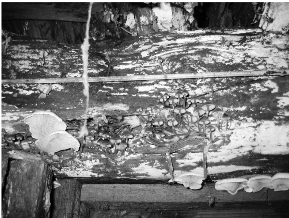
5. att. Ostas noliktavas ēkas (Kurzeme, Liepāja, 1697. g.) griestu sijās identificētas koksnes sēnes Coniophora puteana , Crustoderma dryinum , Hyphodontia arguta , Phlebiopsis gigantea , Comatricha nigra , Mycena stipata un Tapinella panuoides .
