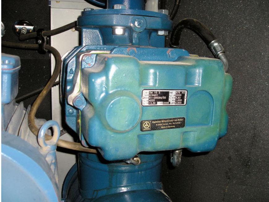
5.att. Aerzen Inc. aerācijas kompresora piedziņa – aerācijas kompresors (2010.gads)
