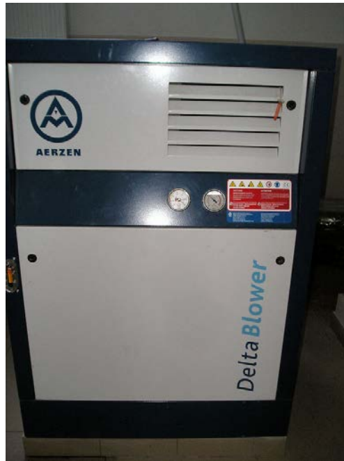
3.att. Pēc rekonstrukcijas uzstādītais Aerzen Inc. aerācijas kompresors Preiļu NAI, kopskats (2010.gads)
