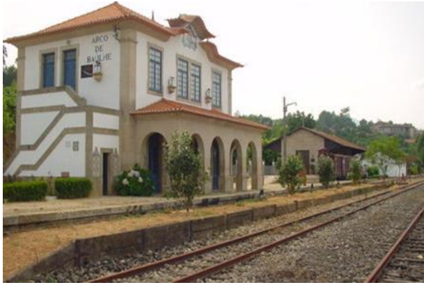
a) Núcleo Ferroviário de Arco de Baúlhe
