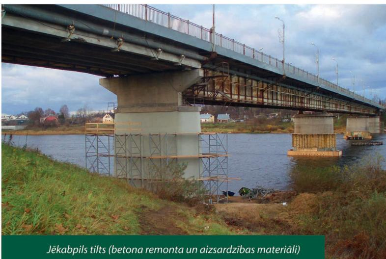
Jēkabpils tilts (betona remonta un aizsardzības materiāli)
